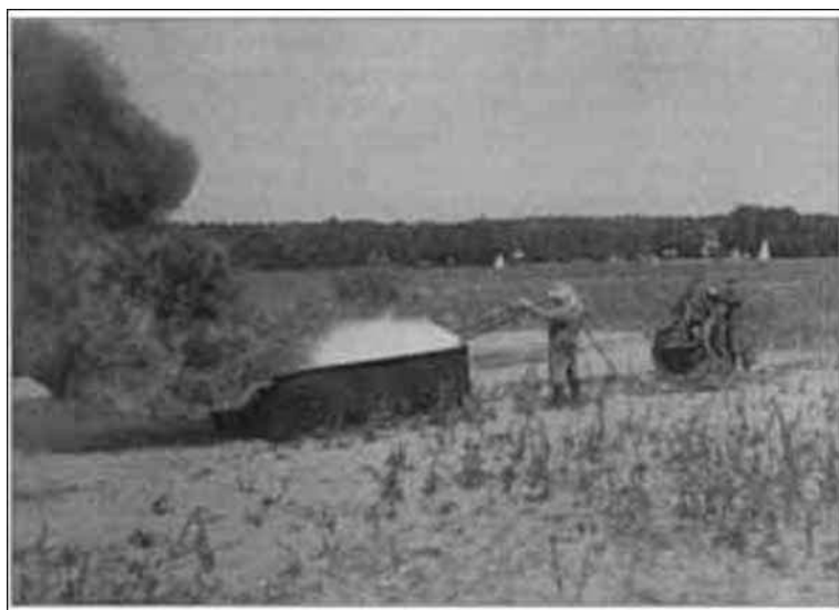
Abb. 2. Fahrbarer Polartota beim Ablöschen eines brennenden Benzoltanks.
